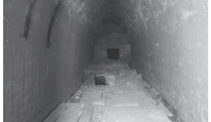
In einem Querstellen - Alte Fundamente von Maschinen
